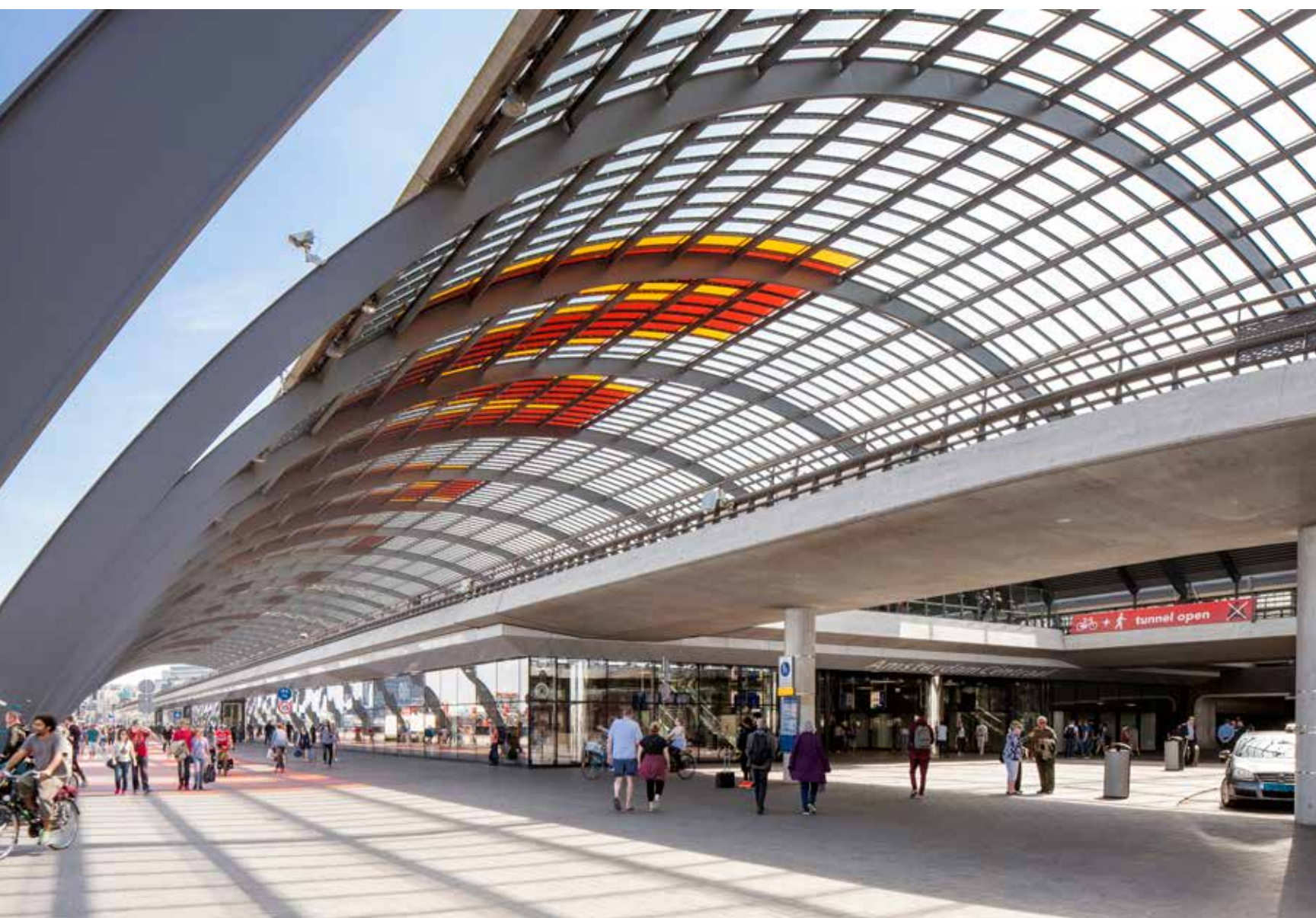
Coating van een staalconstructie in SteelKote bij busterminal Amsterdam 't IJ.
